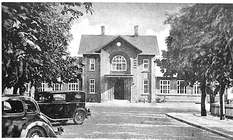
Jernbanestationen i Grenaa. Dens Forside staar omtrent uforandret, som da den opførtes i 1876. (Stenders Forlag. Eneret.)
