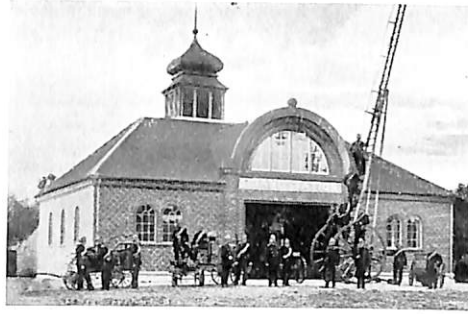
Brandstationen paa Nytorv bygget 1909. Til højre ses den ved den nye Brandordning anskaffede høje Brandstige.
