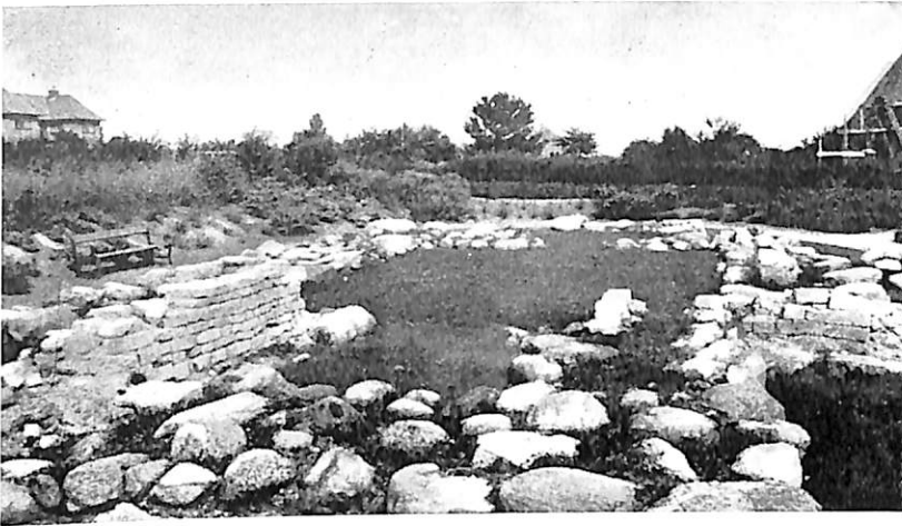
Kirkens Fundament set fra Vest. Bemærk Resterne af Kridtstensmurene til venstre Side (i Taarnbyningen) og til højre (i Vaabenhuset).
