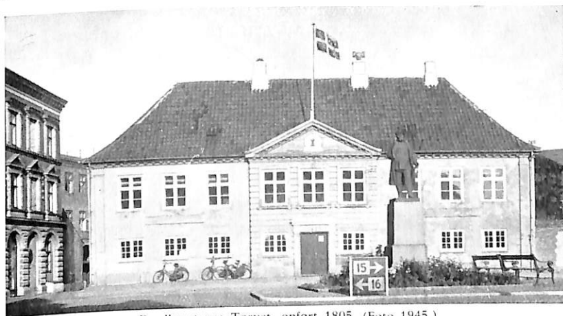
Raadhuset paa Torvet, opført 1805. (Foto 1945.)
