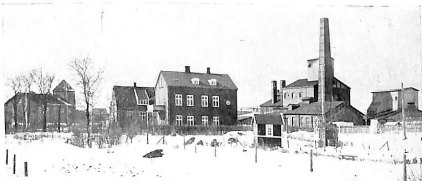
De tekniske Værker. Fra venstre Elektricitetsværket, i Midten Kontor og Direktorbolig, til højre Gasværket. Foto ca. 1940.
